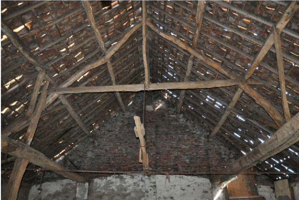
Foto's Binnenkant schuur voor en tijdens de restauratie
