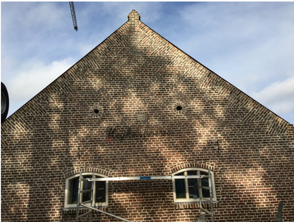
Foto Voorgevel schuur net uit de steigers
